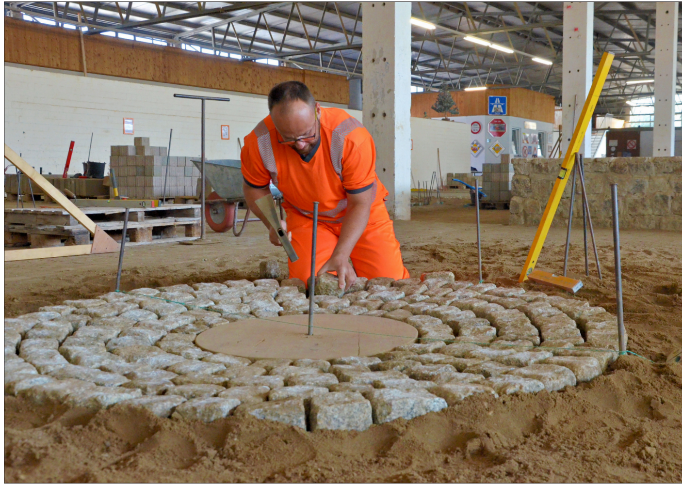
Hendrik Kämmerer ist dabei, die letzten Arbeiten bei einer Baumscheibe zu beenden. Dies ist Teil einer Zwischenprüfung, die auch die Straßenwärter absolvieren müssen. Fotos: Stefan Demps
